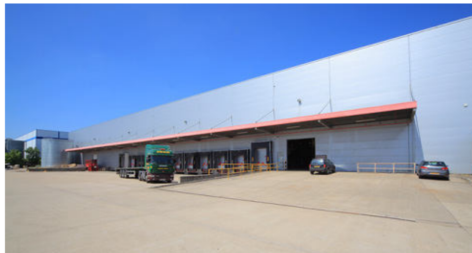
Milton Keynes/Brinklow 90 Standing Way, Nutzfläche 80.300 sf
