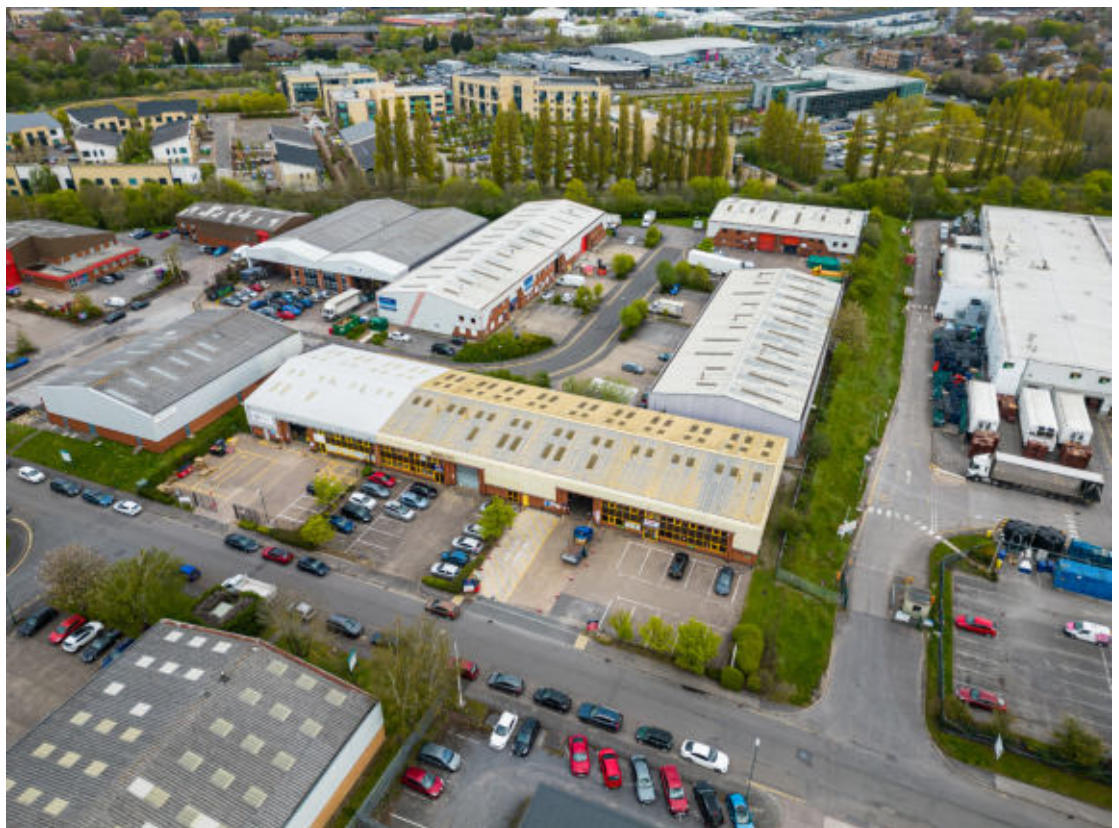
Nottingham, East Midlands 1-3 Longwall Avenue + 1-8 Linkmal Close NG2 1NA, 21.300 sf Nutzfläche
