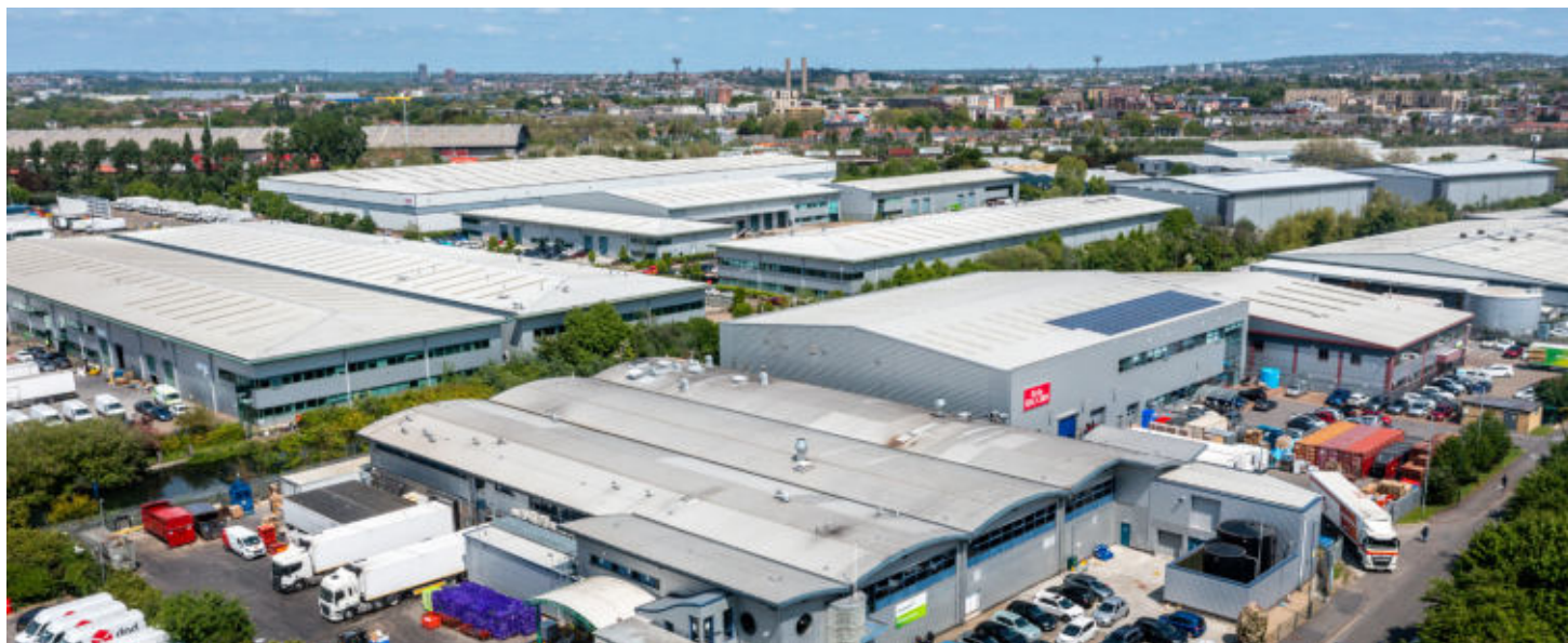
Logistikimmobilie im London Park Royal 8 Willen Field Road NW10 7 AQ Distributionslager Greencore
