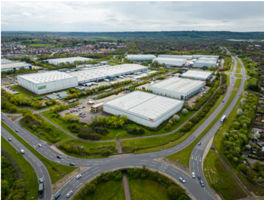
Die Photos zeigen die ersten, auf Ebene der Zweckgesellschaft, vertraglich gesicherten Logistikimmobilien
