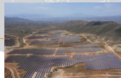
Photovoltaikpark „La Cabrita“, Spanien Standort: Süd-Spanien Kapazität: 50 MWp Inbetriebnahme: Oktober 2021
