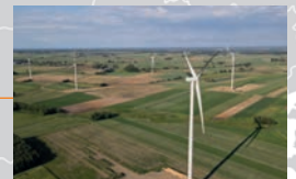
Windpark „Triwa“, Polen Standort: Kepno, Polen Kapazität: 19,8 MW Inbetriebnahme: Juli bis September 2022
