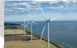
Windpark „Mads“, Dänemark Standort: Kappel, Dänemark Kapazität: 25,05 MW Inbetriebnahme: April - Juni 2017
