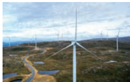
Windpark „Tesla“, Norwegen Standort: Süd-Norwegen Kapazität: 150 MW Inbetriebnahme: 2012-2018
